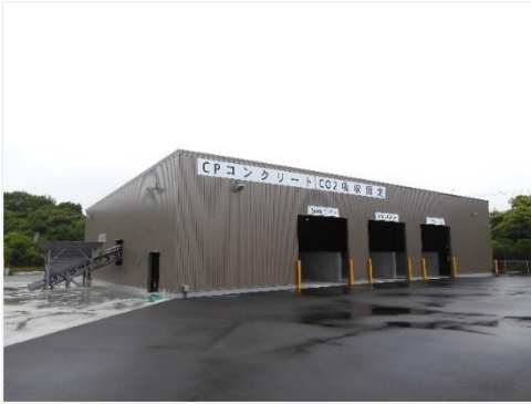
写真 1 : CP センター分級設備棟
